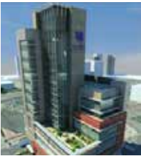
Al Sebeih Hospital, Kuwait - HDPE
