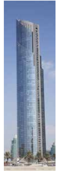
D1 Tower, UAE - Studor
